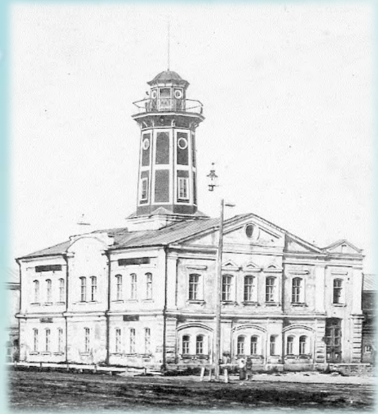
Здание городской ратуши, 1900-е гг
